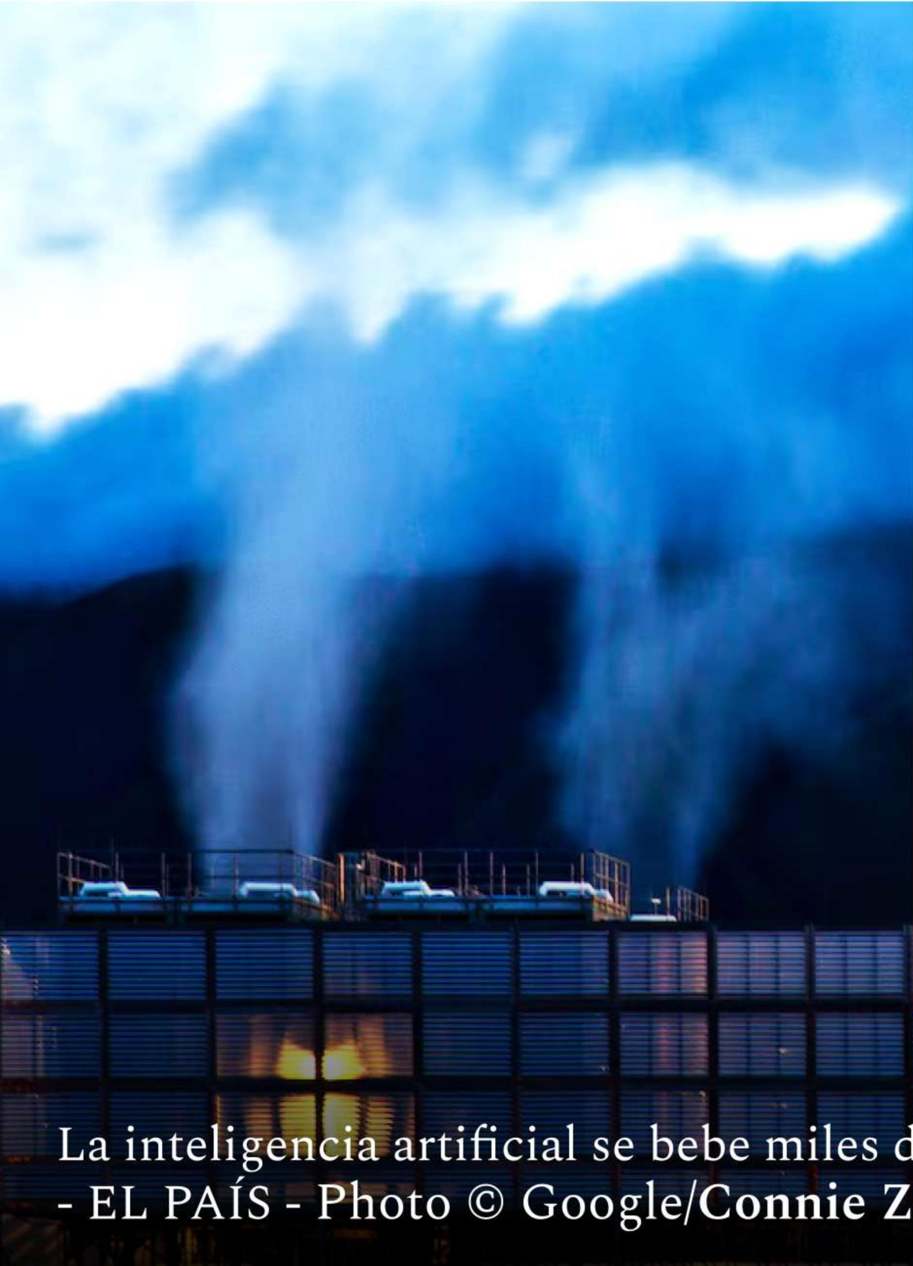
**“Una torre de refrigeración suele consumir entre uno y cuatro litros de agua (hasta nueve en verano) por cada kWh de energía del servidor”**
